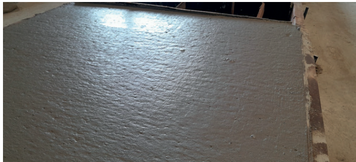
Figura 6 - Placa de pavimento com 12,5 kg/m³ de DRYDuraCon®, com exsudação controlada.
