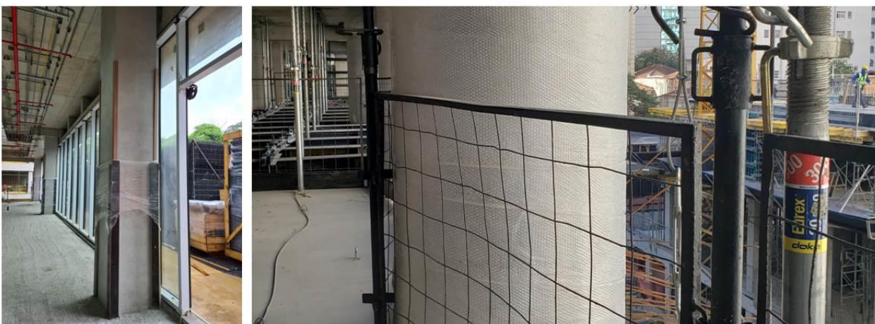
Figura 18: Cantoneiras e plástico bolha para proteger o acabamento do concreto de pilares (Fonte: Arquivo S. Takashima)
