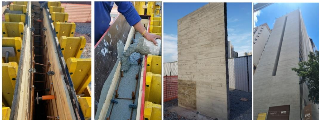
Figura 12: "Mockup" das paredes das fachadas concretadas com forma de madeira ripada e fachada final acabada (fonte: arquivo S. Takashima)
