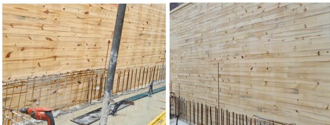
Figura 9: Forma de madeira ripada, controle rigoroso da umidade das ripas no recebimento – (Fonte: Arquivo S. Takashima)
