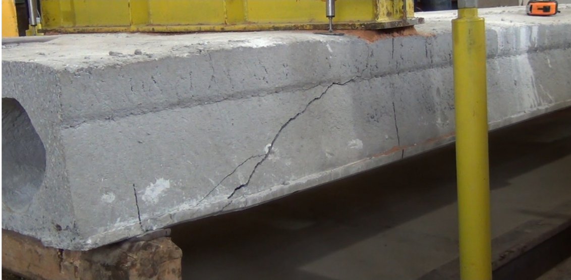
Fig. 15 – Ruptura por cisalhamento – Protótipo 2 CAA (2)
