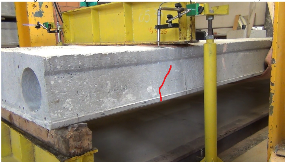
Fig. 17 – Fissura por flexo-cisalhamento – Protótipo 3 CAA + DRYI (1)
