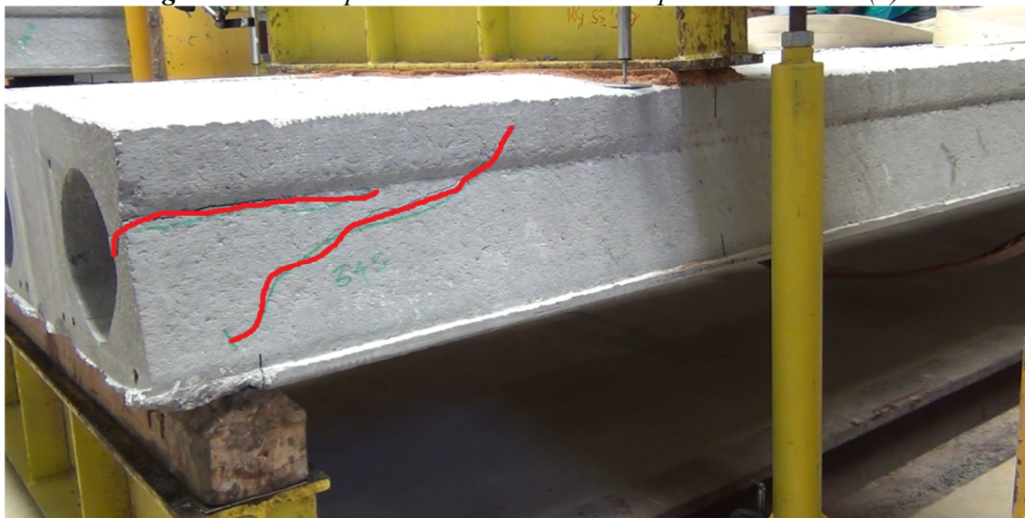
Fig. 11 – Fissura por cisalhamento – Protótipo 1 CAA + BAR (2)
