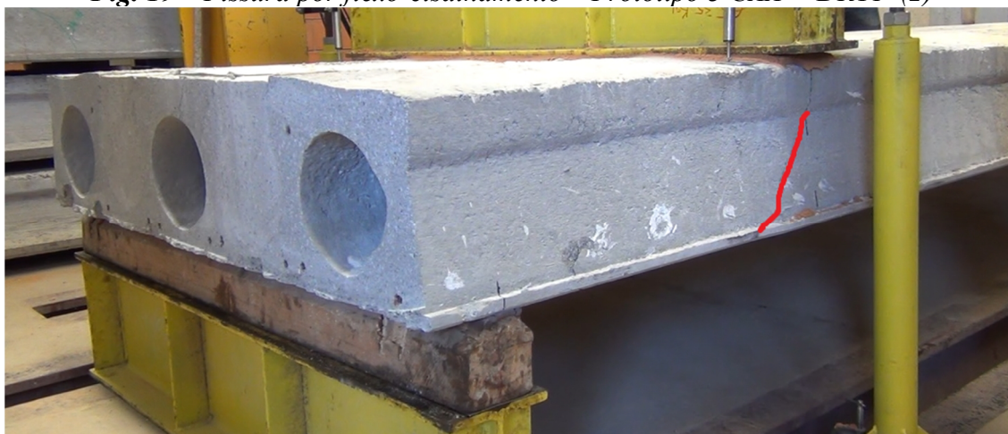
Fig. 19 – Fissura por flexo-cisalhamento – Protótipo 3 CAA + DRYI (2)
