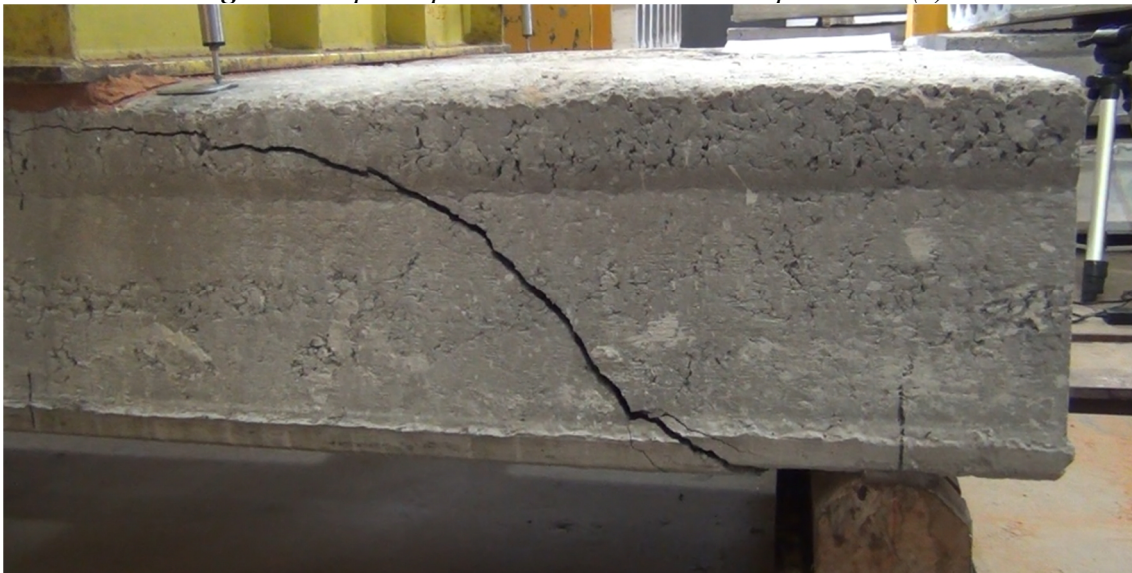
Fig. 16 – Ruptura por cisalhamento – Protótipo 2 CAA (2)
