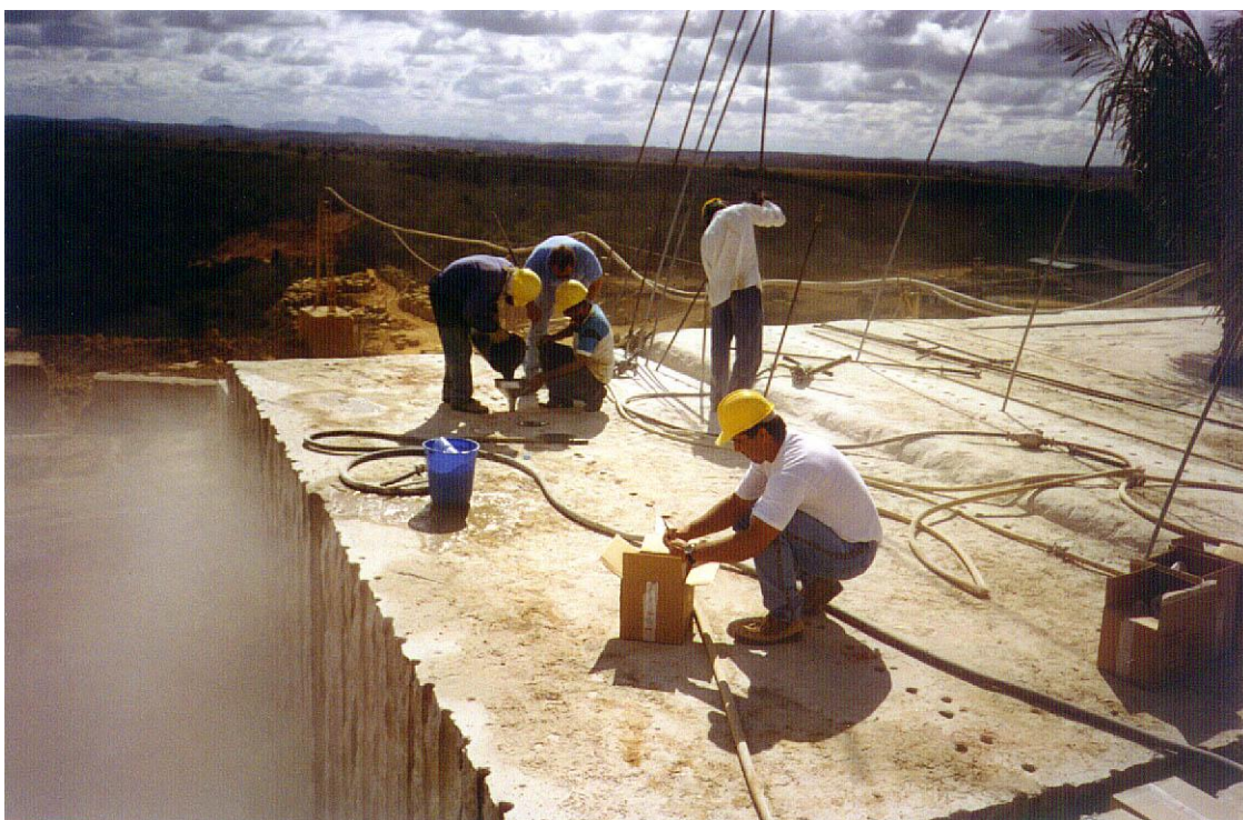
Aplicação da argamassa expansiva Fract.Ag na lavra de maciço rochoso.
