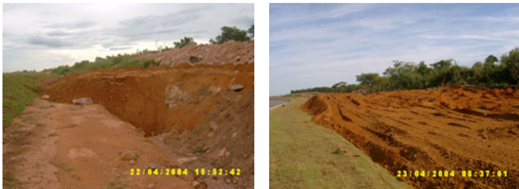
Figura 2.4 – Cobertura de terra compactada (tirada pela Technoblast)
