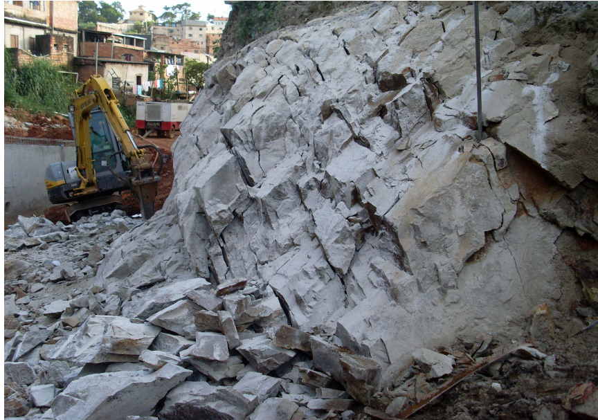
Figura 2.5 – Oito horas após aplicação da argamassa expansiva na rocha.
