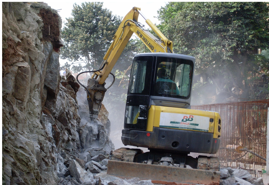
Figura 2.6 – Mini escavadeira de 5 t, acoplada com rompedor hidráulico de 300 kg, para fazer o deslocamento da rocha já fraturada.
