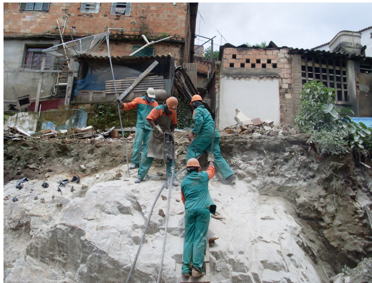
Figura 2.2 – Rocha onde foi feita a furação para a aplicação da argamassa expansiva em escala industrial.
