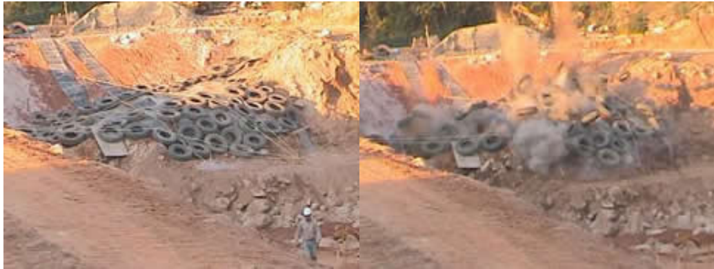
Figura 2.3 – Cobertura de pneus, cordas e correias transportadoras (tirada pela Technoblast)
