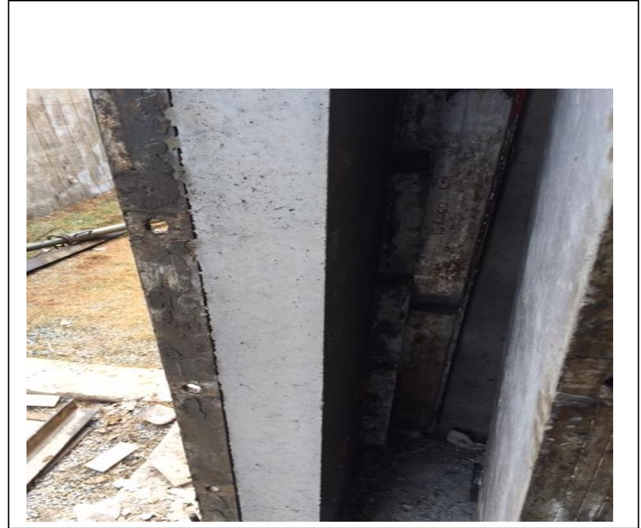
Detalhe da parede com adição D1
