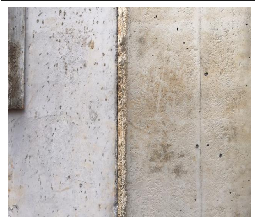
Detalhe lado direito D1 e lado esquerdo concreto convencional
